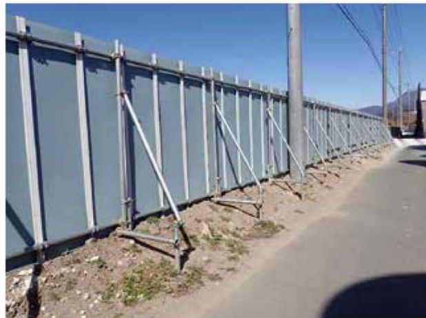
高い安全鋼板で「壁」を設置した事例
